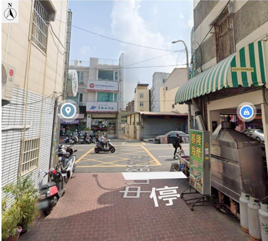
圖 3 無號誌化路口支線道標示設置示意圖
