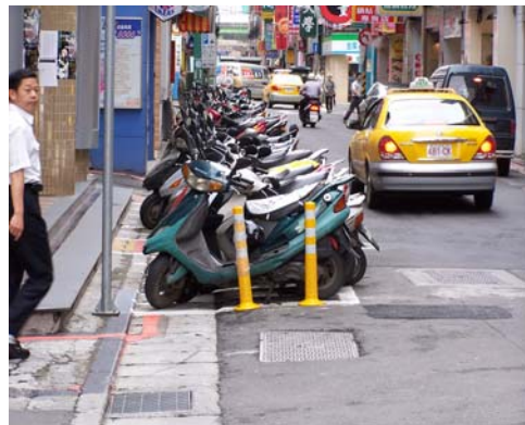
圖 12 機車停車格外緣設置回復型導桿
