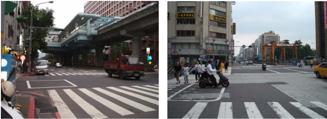
圖 2. 待轉區位置超出路緣或與行人穿越道標線衝突照片
