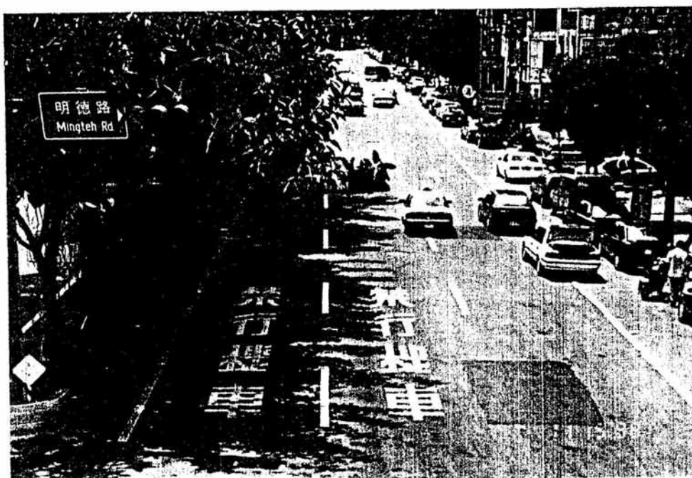
圖一：快慢車道分隔線設置不當
