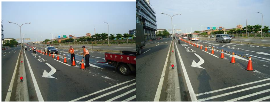
圖 6 布設交通錐及安全戒護情形
