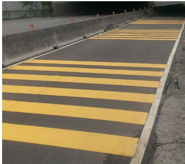
圖 9 中壢市中豐北路改良式減速標線繪設後現場照片
