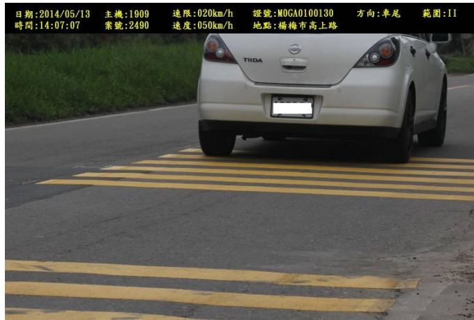
圖 14 楊梅市高上路標線劃設後日間測速照片
