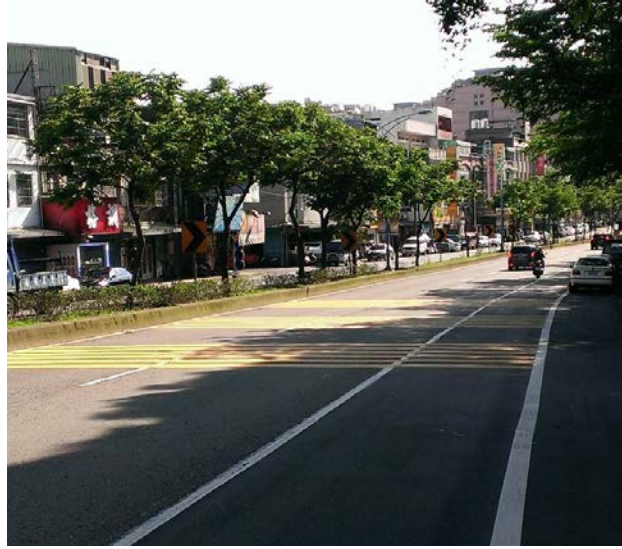
圖 10 龜山鄉長壽路改良式減速標線繪設後現場照片
