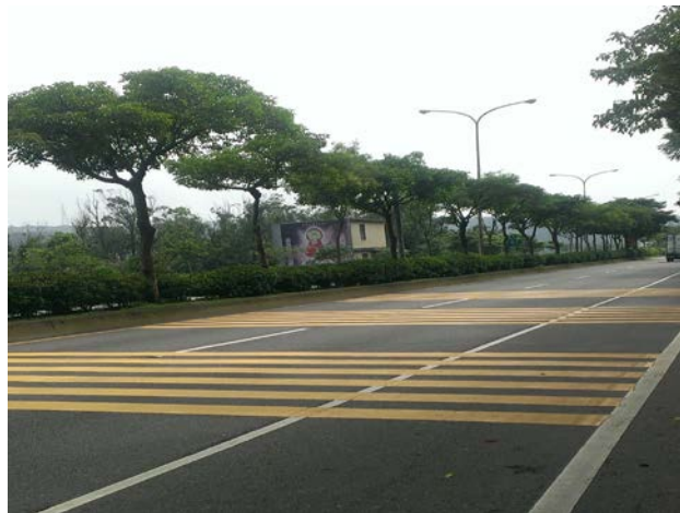
圖 11 楊梅市中山南路改良式減速標線繪設後現場照片
