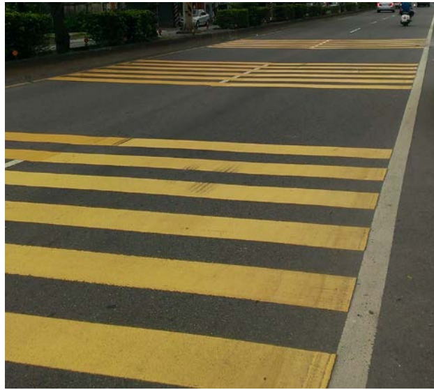
圖 8 龍潭鄉中豐路上林段改良式減速標線繪設後現場照片
