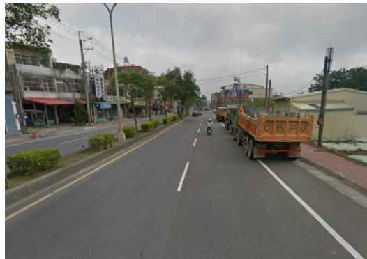
圖 12 龍潭鄉中豐路上林段現場路況
