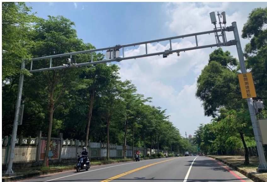
圖 2 區間測速裝置(高雄市松藝路)
