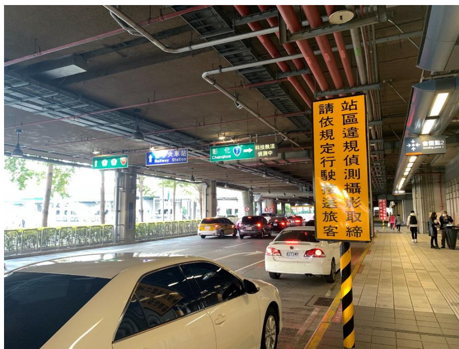
圖3 高鐵臺中站接送區1樓上客區現場照片
