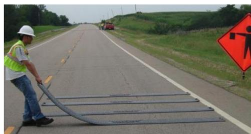
圖 10 可攜式振動帶設置情形
