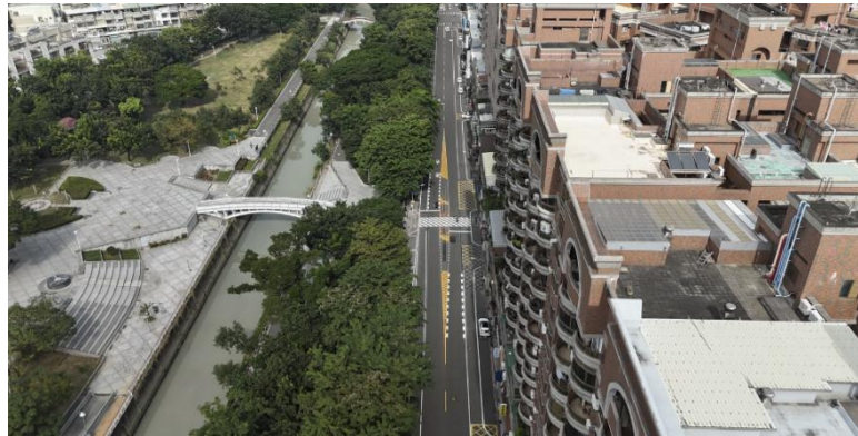
圖 13 高雄市三民區河堤路 512 號前路段型庇護島及 2+1 車道
