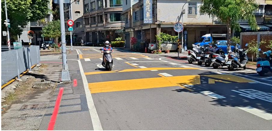
圖 10 減速台可使機車平順通過且較減速丘更具行駛穩定性
