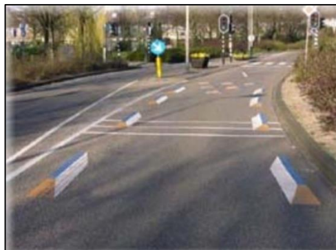
圖 2 彎道路段設置彩色立體標線
